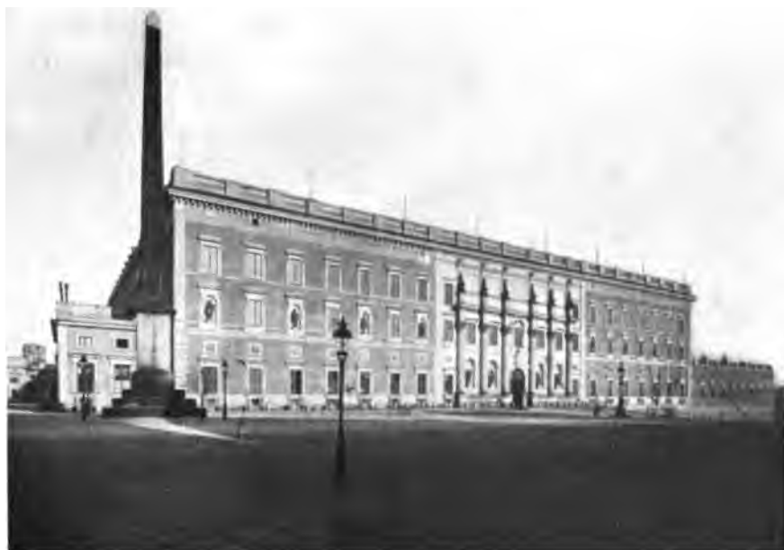
Château de Stockholm (façade méridionale).
